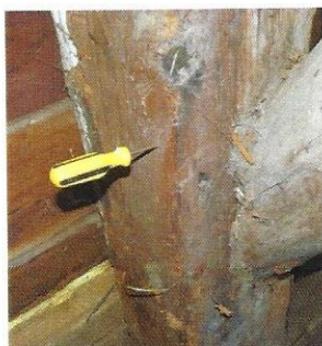
Priem in te drijven in onderdeel 1 van spant 1
