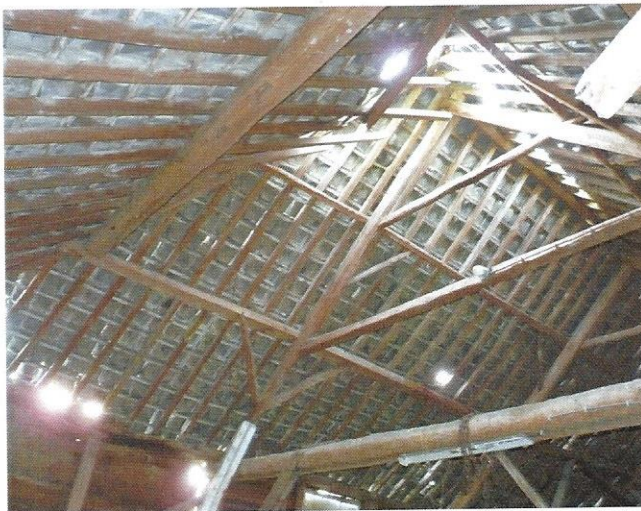
Bovenste gording bezweken, sporen los van hoekkeper.
