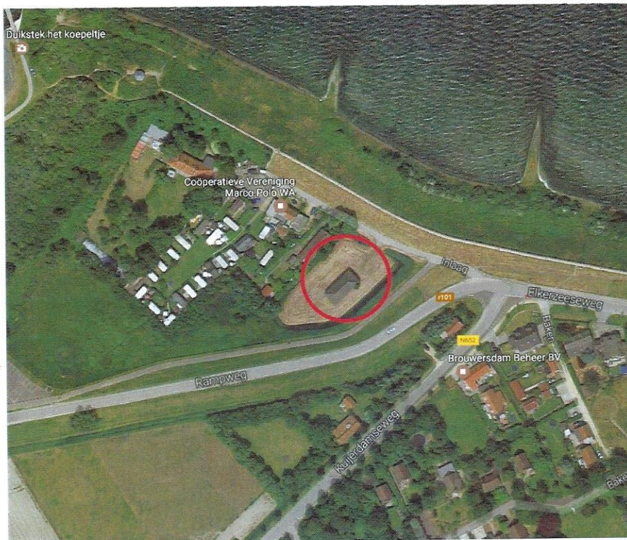
Schuur aan de Inlaag 8 te Scharendijke
